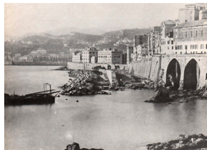
Foto d'epoca. La Circonvallazione a mare in costruzione (ca. 1880) all'altezza delle Grazie.
