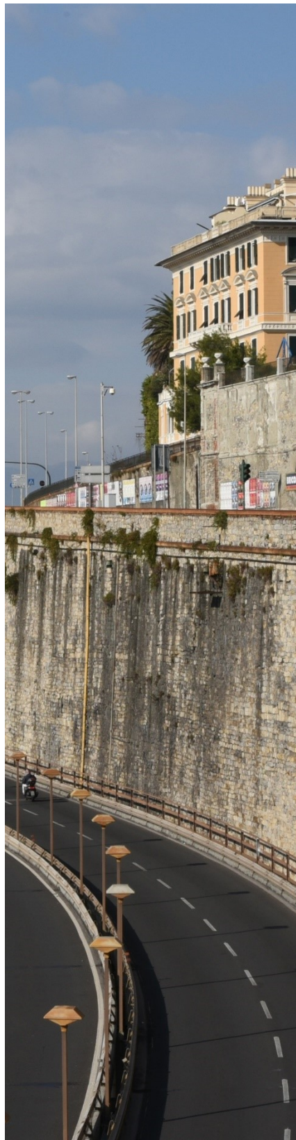
IL MURO DI CORSO AURELIO SAFFI
